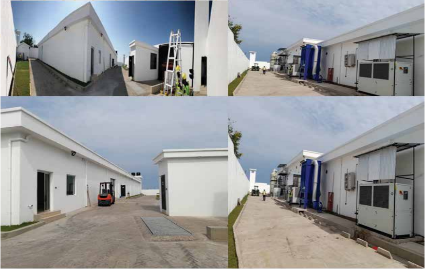
Picha Na. 14: Muonekano wa jengo la kiwanda cha kusafisha dhahabu jijini Mwanza
